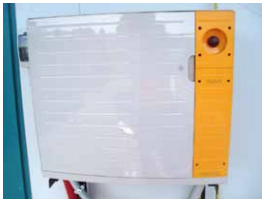
Figura 10 Cuadro de obra
